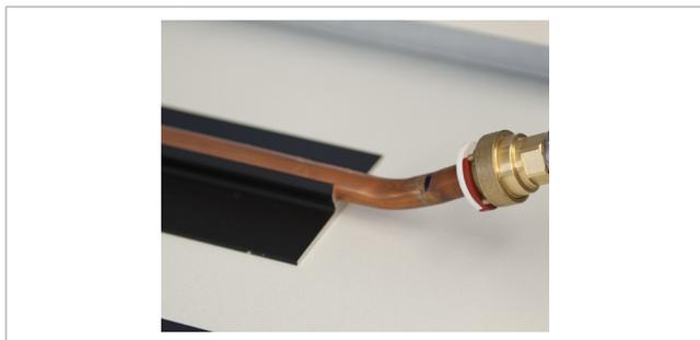
3) La tubazione tagliata, calibrata ed opportunamente sbavata prima dell'inserimento nel raccordo, deve essere leggermente lubrificata con grasso silconico per favorirne lo scivolamento senza danneggiare l'anello O-ring del raccordo. La superficie del tubo deve essere pulita e priva di impurezze che impedirebbero la tenuta dell'anello. Evitare di lubrificare la parte interna del raccordo onde evitare di ferirsi inavvertitamente con l'anello dentato di bloccaggio in acciaio.
