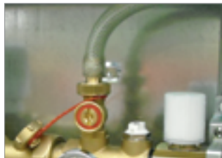
F. Collegare un comune tubo di gomma al rubinetto di scarico (11) situato sul raccordo intermedio del collettore di ritorno R553V per consentire il carico.
