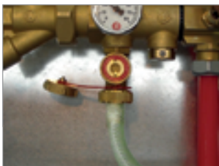
G. Collegare un altro tubo in gomma al rubinetto (11) situato sul raccordo intermedio del collettore di mandata R553M per consentire lo scarico.
