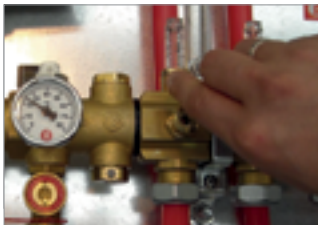
C. Per procedere al riempimento dell'impianto verificare che le memorie meccaniche di tutti i detentori posti sul collettore di mandata R553M siano completamente aperte utilizzando l'apposita chiave R558.
