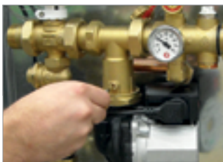
A. Chiudere le valvole a sfera (8) posizionate a monte e a valle del circolatore.
