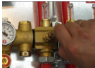
D. Chiudere tutti i detentori sul collettore di mandata R553M del secondario utilizzando l'apposita chiave R558 (brugola esagono 5 mm).
