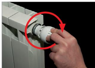
**3)** Chiudere a fondo la testa ruotando la manopola (portare la manopola in posizione \*).
