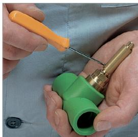
oppure montare con la stessa procedura l'ulteriore prolunga d'asta per la versione H173B. Nel caso di utilizzo del rosone con cappuccio cieco H174A la manovra del rubinetto viene effettuata utilizzando la farfalla già presente sui rubinetti H173. A lavori murari terminati eliminare la protezione da cantiere del rubinetto, pulire la filettatura del vitone da eventuali impurezze presenti ed avvitare il
